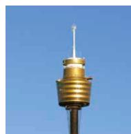
塔顶的尖针用作通信和导航。
