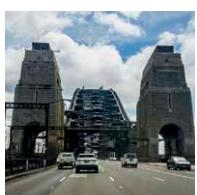
Prima dell'apertura del ponte, 96 locomotive a vapore furono posizionate sulla struttura per testare la sua capacità di carico.
