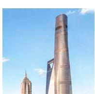
Au lieu d'une structure traditionnelle en poutres d'acier, la tour est construite autour d'un noyau en béton épais.
