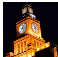
Chacune des quatre faces de l'horloge a un diamètre de 5,3 mètres et se compose de 100 pièces de verre.
