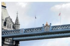
Die Fußgängerstege wurden so konstruiert, dass sie auch bei hochgeklappter Brücke für die Öffentlichkeit begehbar sind.
