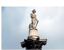
Die Säule selbst wurde aus Granit errichtet, die Statue von Nelson besteht dagegen aus Sandstein.
