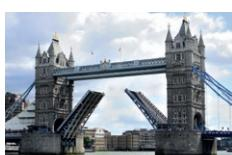
*Le mécanisme de soulèvement du pont était actionné à l'origine par la vapeur, mais il est maintenant actionné par l'huile et l'électricité.*
