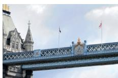
*Les passerelles du niveau supérieur ont été conçues de façon à ce que les piétons puissent traverser le pont même quand il est soulevé.*
