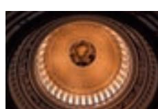
现今“婚礼蛋糕式”的铸铁圆顶修建于 1855 年，其高度是原始圆顶的三倍。
