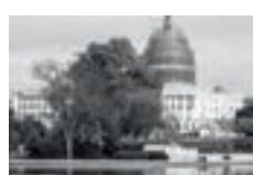
圆顶由 4,041,100 千克铸铁制成。
