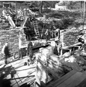
Ouvriers de construction
