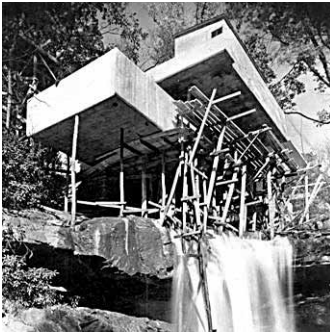
Échafaudage (© F.L.Wright Fdn.)
