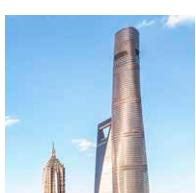
Em vez da estrutura tradicional em viga de aço para o esqueleto, a torre é construída à volta de um núcleo de betão espesso.
