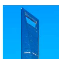
El edificio se construyó empleando secciones modulares que se repiten cada 13 plantas.
