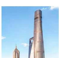
En lugar de usar la tradicional estructura de vigas de acero como esqueleto, la torre se construyó alrededor de un grueso núcleo de hormigón.
