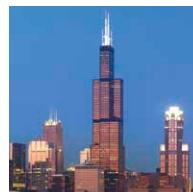
La torre contiene 40,2 km de tuberías, 2.414 km de cableado eléctrico, 129 km de cables de elevador y 145.000 puntos de luz.
