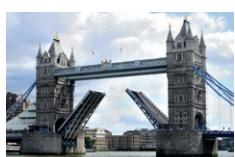
塔桥的起升装置最初由蒸汽提供动力，现在则为油或电力驱动。
