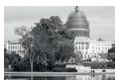
Die Kuppel auf dem Bauwerk besteht aus 4.041.100 kg Gusseisen.
