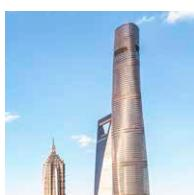
Der Turm wurde um einen dicken Betonkern herum errichtet, der anstelle der sonst üblichen Stahlträgerkonstruktion als Gerüst diente.
