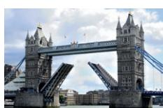
*Le mécanisme de soulèvement du pont était actionné à l'origine par de la vapeur, mais il est maintenant actionné au moyen d'huile et d'électricité.*
