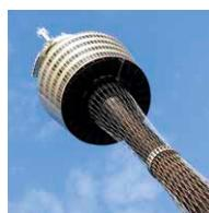
56 cables la estabilizan; si cada hebra de dichos cables se colocara en línea recta una tras otra, llegarían desde Sídney hasta Nueva Zelanda.
